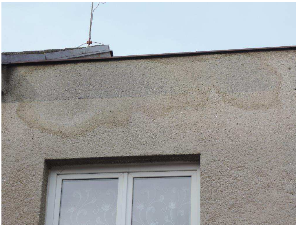
Foto č.1 – Pohled na východní část fasády - pod střechou vlhké zdivo
