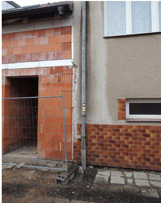
Foto č.4 – Pohled na východní část fasády – u okapu vlhké zdivo, v rohu odloupená fasáda
