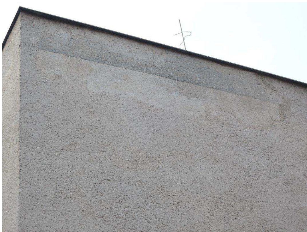
Foto č.6 – Pohled na severní část fasády - pod střechou vlhké zdivo
