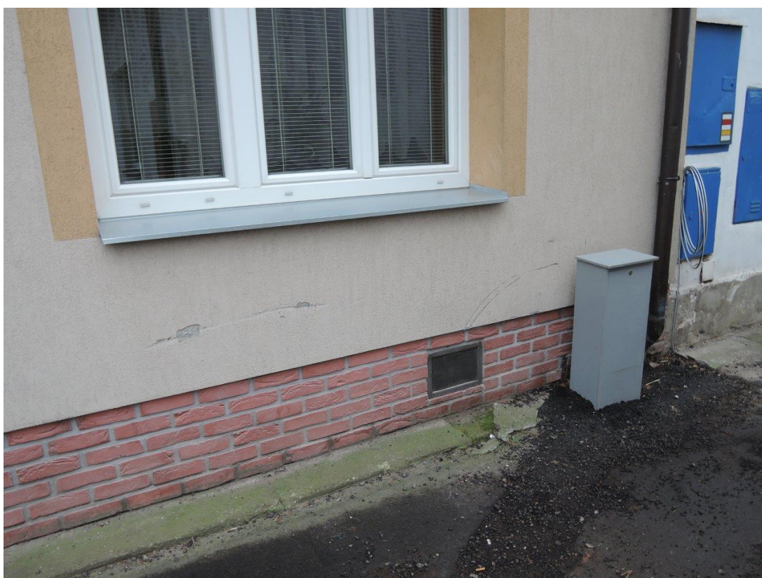
Foto č.2 – Pohled na severní část fasády -mechanické poškození
