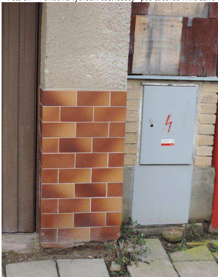
Foto č.2 – Pohled na východní část fasády – odhalené základové zdivo
