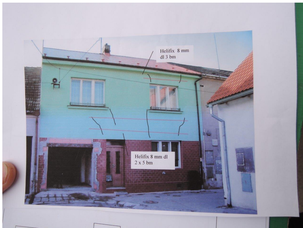
Foto č. 4 - archivní foto před zateplením objektu – viditelné původní praskliny na fasádě
