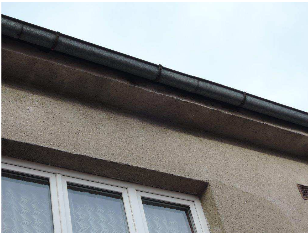
Foto č.5 – Pohled na východní část fasády - pod střechou vlhké zdivo
