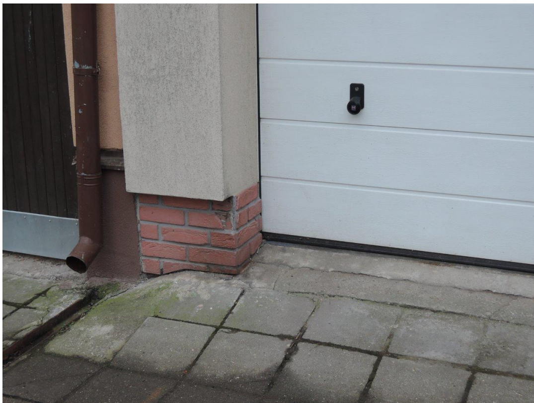
Foto č.1 – Pohled na severní část fasády -mechanické poškození obkladu
