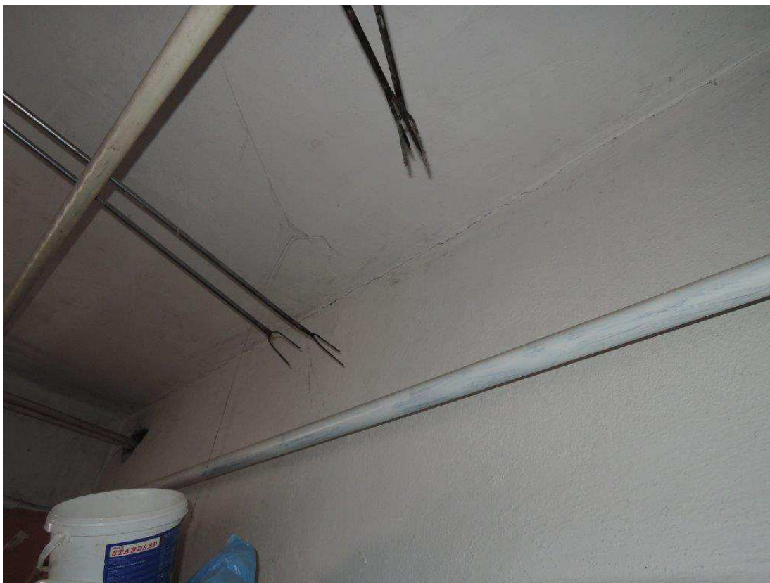
Foto č.10 - technická místnost, kotelna - drobné praskliny v rozích
