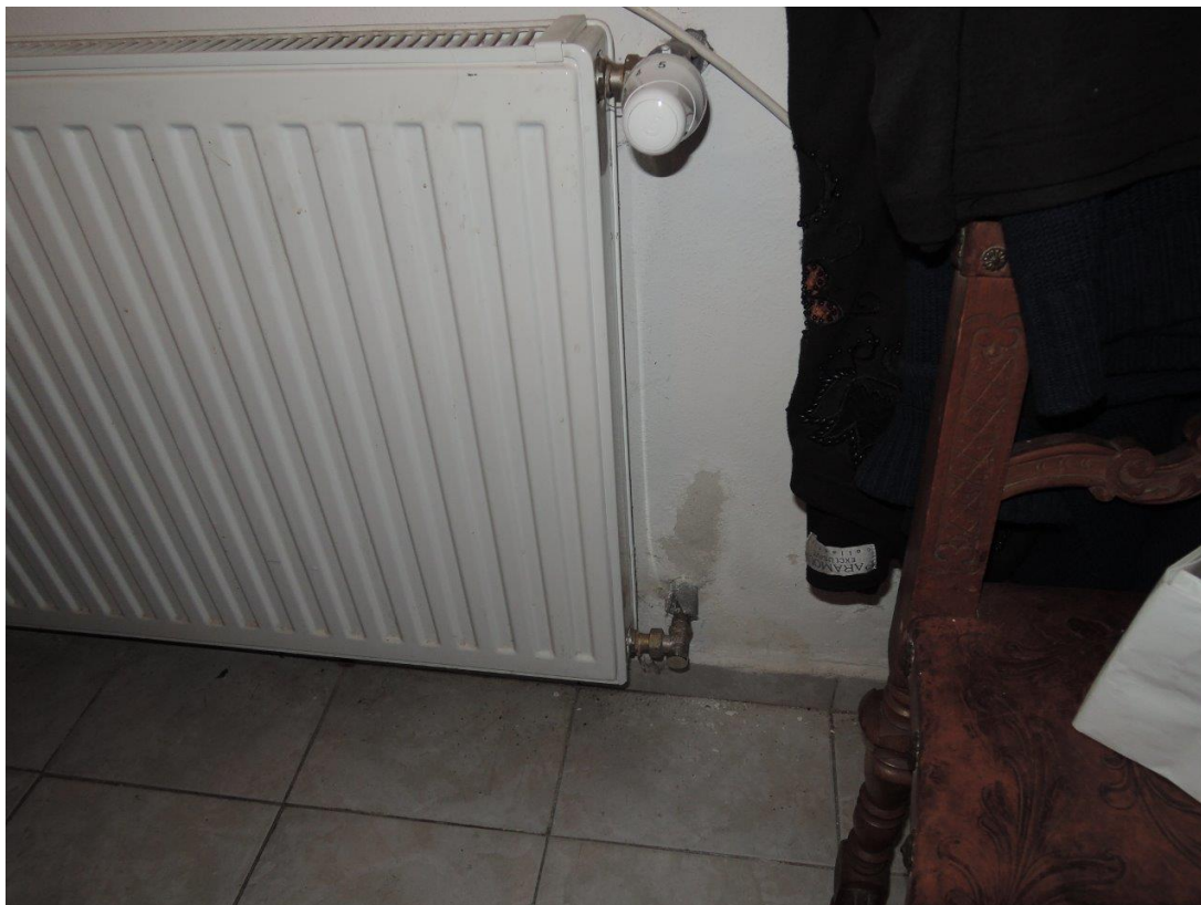
Foto č. 16 - obývací pokoj – vlhká omítka, plíseň
