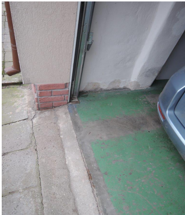
Foto č.3 – Pohled na severní část fasády - vlhkost v garáži
