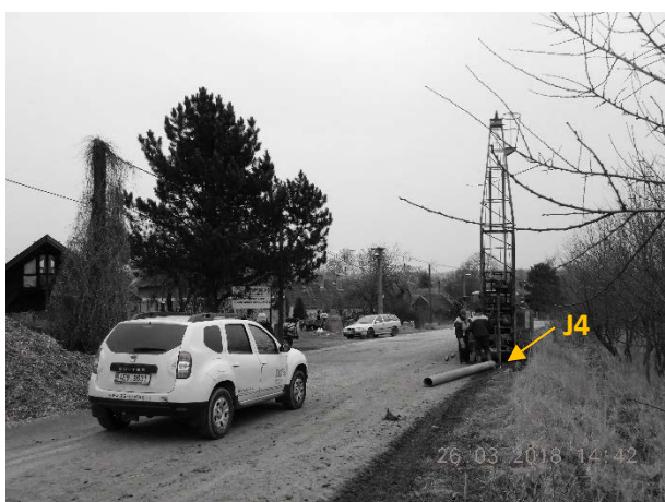
Obr. 3,4: Hloubení sondy J4 strojní vrtnou soupravou UGB, pohled k jihovýchodu, místo vrtu J6 v pohledu k severu.
