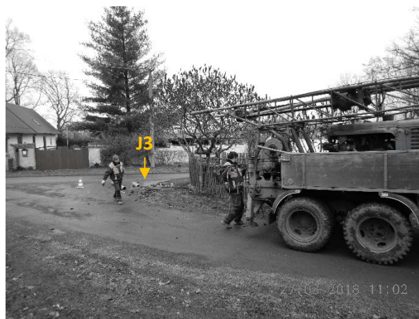
Obr. 1,2: Hloubení sondy J2 strojní vrtnou soupravou UGB, pohled k východu; místo vrtu J3 v pohledu k západu.
