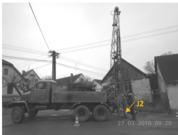
Obr. 1,2: Hloubení sondy J2 strojní vrtnou soupravou UGB, pohled k východu; místo vrtu J3 v pohledu k západu.
