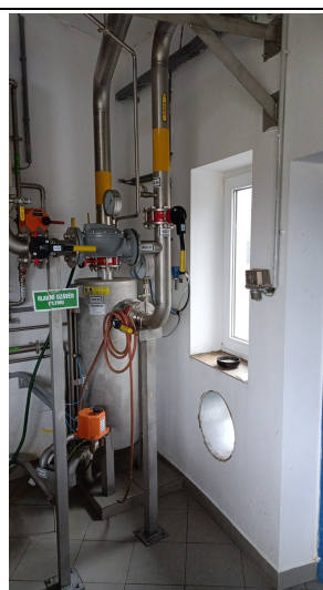
Kompresorovna – místo napojení potrubí bioplynu
