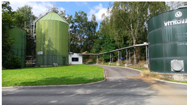
Prostor pro osazení KGJ. Selené vyhřívací nádrže. Bílý objekt je kompresorovna. Objekt vpravo je plynojem.
