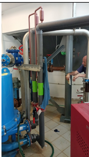
Strojovna ohřevu kalu. Modrý je tepelný výměník voda-kal. Rozvody teplé vody, kde se napojuje rozvod od KGJ.
