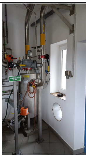
Kompresorovna – místo napojení potrubí bioplynu
