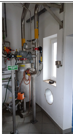
Kompresorovna – místo napojení potrubí bioplynu
