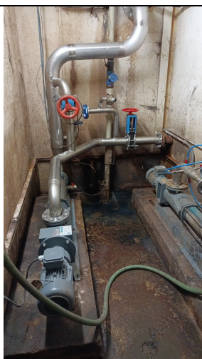
Čerpárna kalu k zahuštění (čerpadlo napravo). Vlevo čerpadlo zahuštěného kalu.
